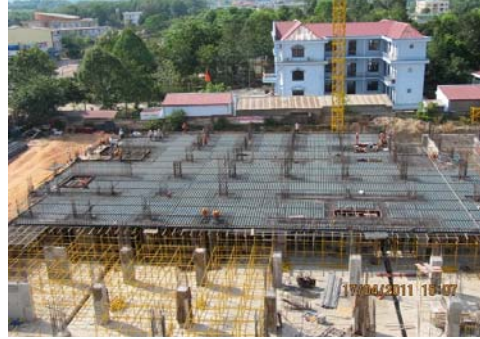
Hình 2. Công trình Long Thanh Plaza – Đồng Nai
