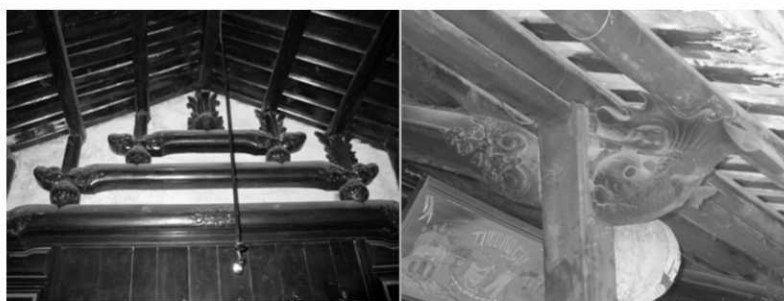
Hình 3. Chi tiết kiến trúc ngôi nhà gỗ truyền thống
