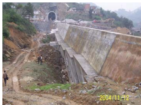
Hình 2. Tường chắn tuyến Thành Đô - Trùng Khánh, tỉnh Tứ Xuyên, Trung Quốc
