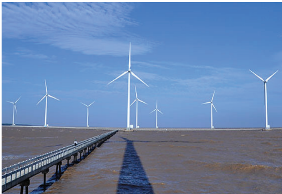
Nhà máy điện gió Bạc Liêu.
