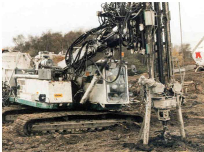
Hình 2. Phương pháp trộn khô dưới sâu
