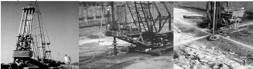
Hình 1. Phương pháp trộn ướt dưới sâu
