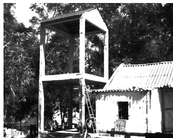
Hình 6. Lõi nhà bằng kết cấu bê tông cốt thép chịu lực
