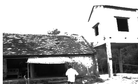
Hình 6. Lõi nhà bằng kết cấu bê tông cốt thép chịu lực
