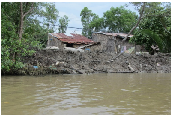
Hình 10. Xói lở bờ kênh tại vị trí sau khi nạo vét kênh đổ bùn đất mép bờ (Ảnh: Lê Thanh Chương, 2009).
