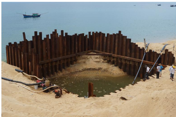
Hình 6. Cừ thép hố móng và hệ thống tiêu nước hố móng
