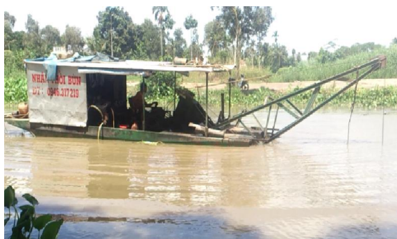
Hình 5. Thi công nạo vét kênh rạch bằng tàu hút bùn
