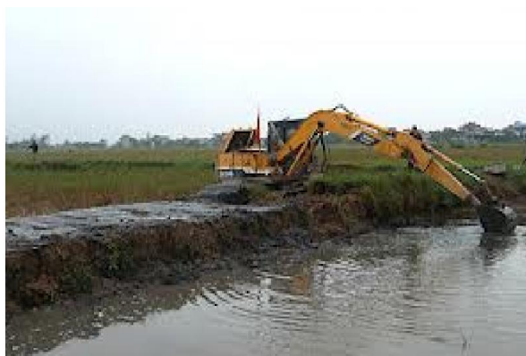
Hình 4. Thi công nạo vét kênh rạch bằng máy đào đứng trên bờ
