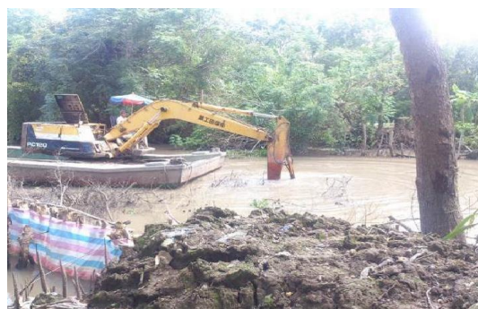
Hình 6. Thi công nạo vét kênh rạch bằng máy đào đứng trên xà lan
