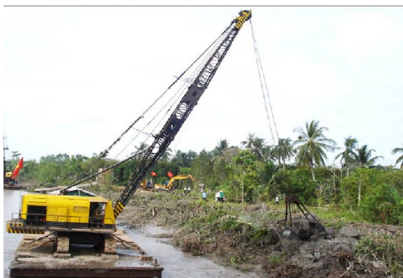
Hình 3. Thi công nạo vét kênh rạch bằng máy đào gầu dây
