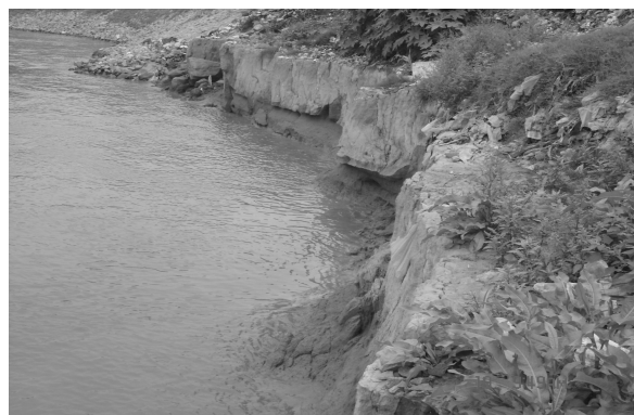
Ảnh 2: Đoạn từ K32+490 đến K32+650 Đoạn Tuyến Suối m, i kì bị xói lở mạnh, tạo thành hố sâu, nhiều chỗ xói lở vào m, i kì từ 2-3m, m, i thủng thủng (Kì Chi Sông).
