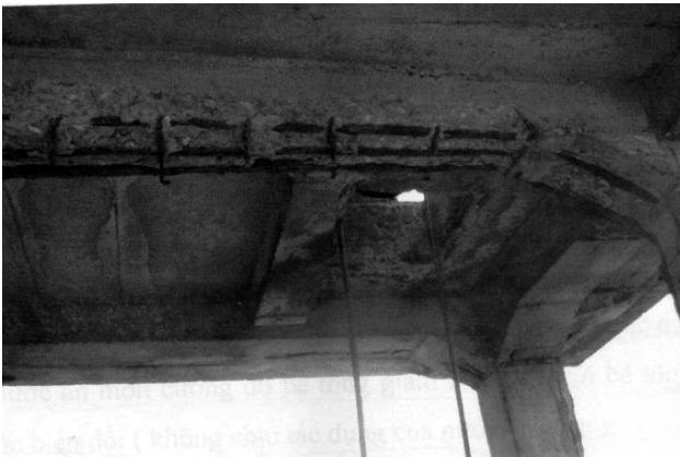
Hình 2.3 : Bề mặt cốt thép lộ ra ngoài sau 22 năm - Nam Định
