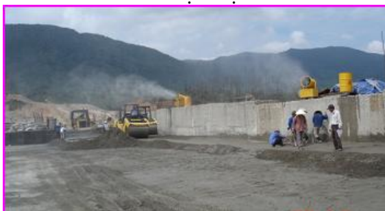
Hình 6: Sử dụng máy phun s-ơng giữ ẩm, hạ nhệt môi tr-ờng thi công
