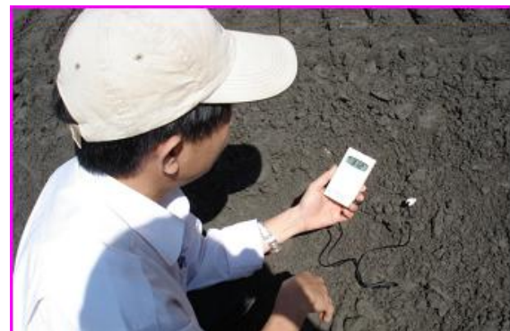
Hình 5: Đo nhệt độ hỗn hợp vữa BTĐL tại khối đổ
