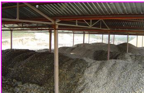
Hình 4: Đá dăm đ-ợc che mát, t-ới ẩm để hạ nhệt
