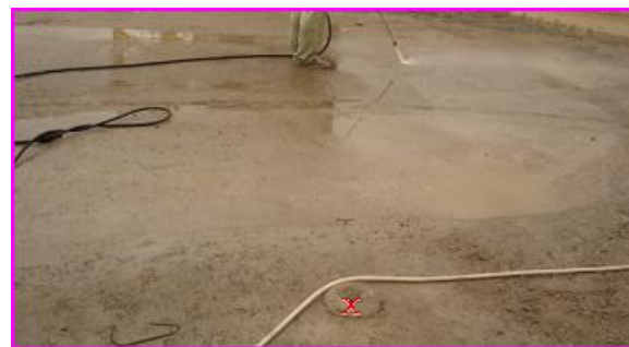
Hình 7: Tạo lỗ (x) để đo diễn biến nhệt độ khối đổ
