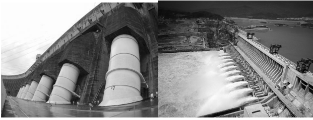
Hình 6. Kết hợp hệ thống đường ống kỹ thuật và máy móc trong hình thức kiến trúc công trình ở đập Itaipu-Blazil và đập Tam Hiệp-Trung Quốc
