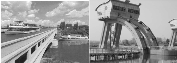
Hình 1. Về đẹp mỹ thuật trong hình khối kỹ thuật của kiến trúc công trình thủy lợi (cầu máng Magdeburg – Đức và gian máy đóng mở tời điện của cống ngăn sông Tam Xoa – Trung Quốc)
