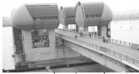
Hình 8. Bộ phận điều khiển hệ thống cửa van của cống đập ngăn mặn ở Nhật Bản
