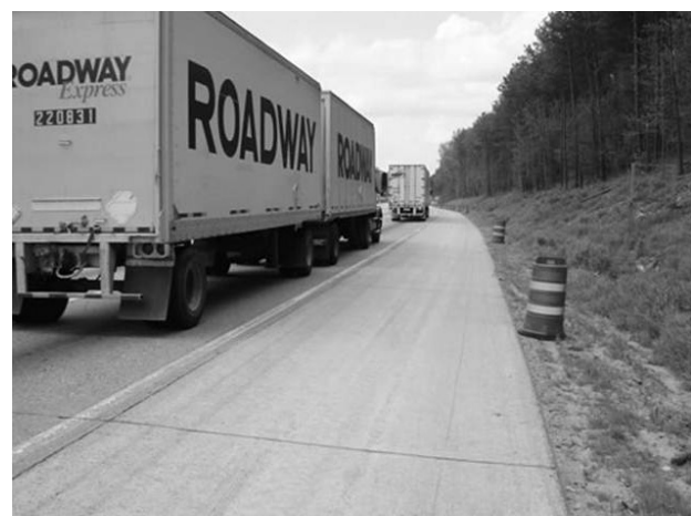
Hình 6. Khe ngang đã được xẻ trong xây dựng mặt đường BTĐL
