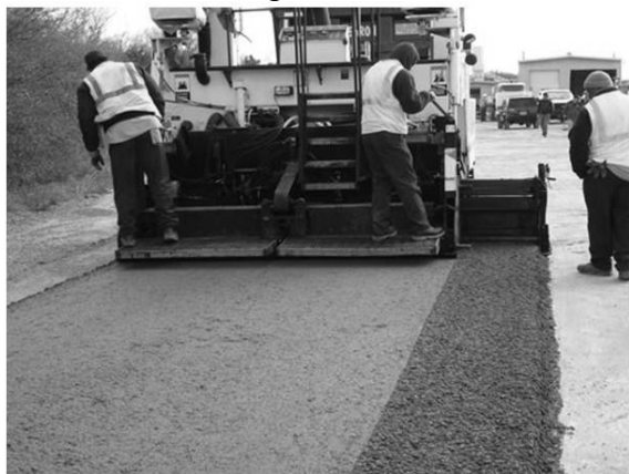
Hình 3. BTĐL được rải bằng máy rải thông thường
