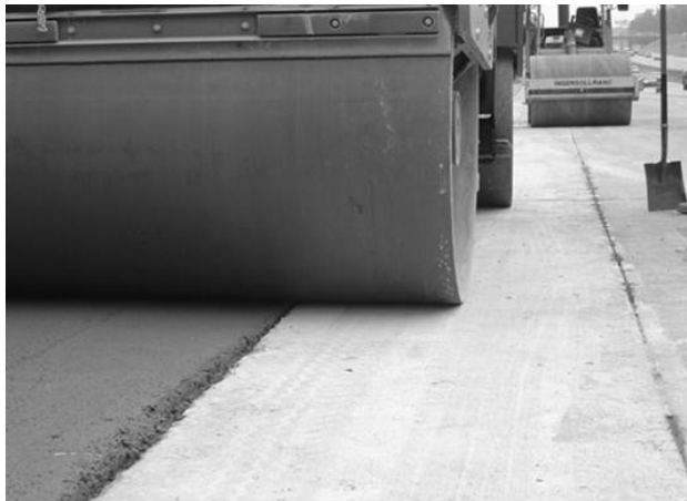
Hình 4. Đầm chặt BTĐL bằng máy lu
