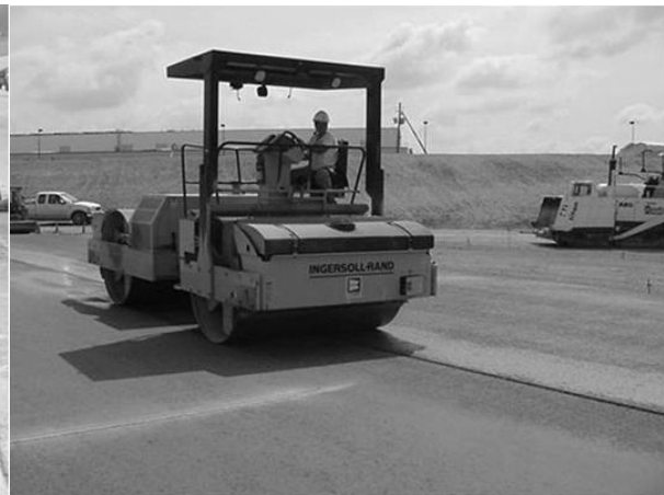
Hình 4. Đầm chặt BTĐL bằng máy lu
