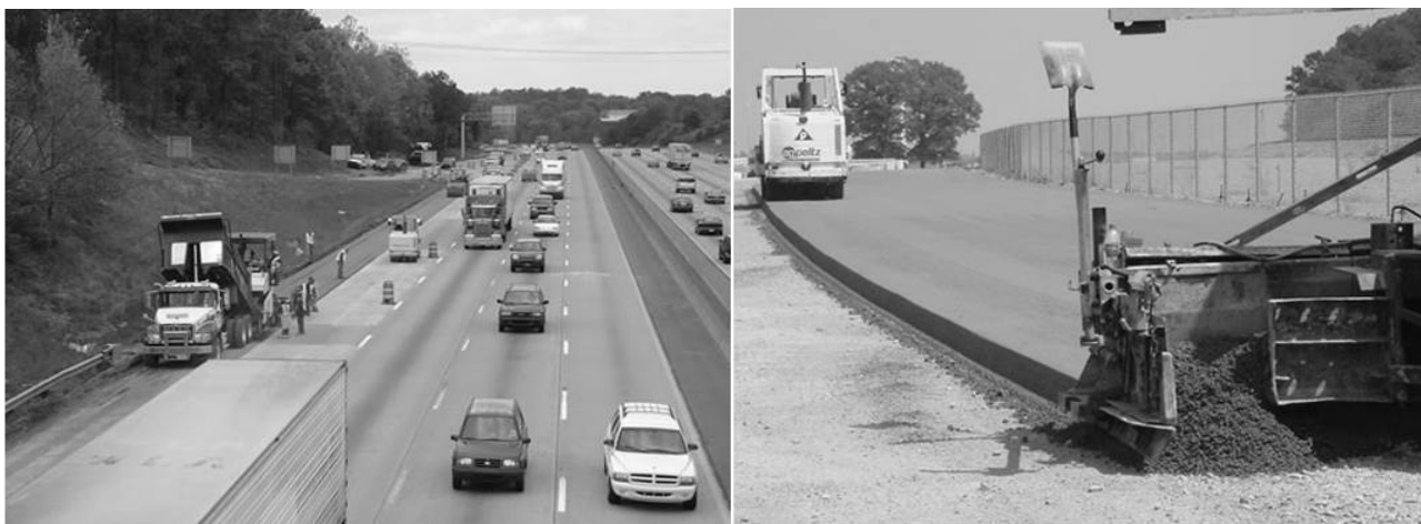
Hình 7. Toàn cảnh xây dựng mặt đường BTĐL
