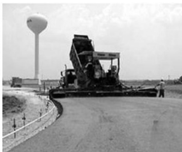
Hình 2. Thi công đường bằng BTĐL
