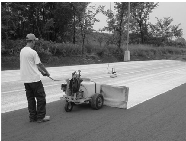
Hình 5. Bảo dưỡng BTĐL mặt đường
