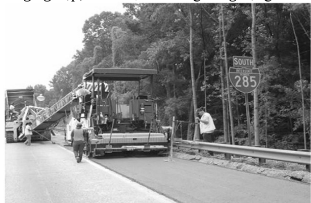
Hình 1. Xây dựng lề gia cố trên đường I - 285 ở thành phố Atlanta - Mỹ, 2004
