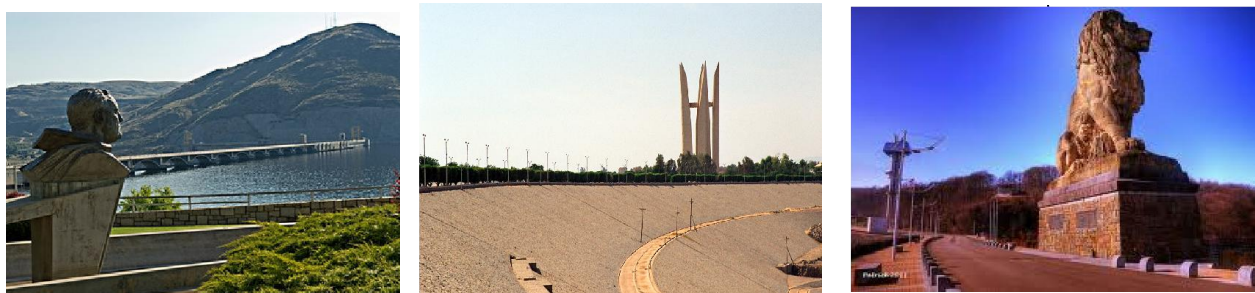
Hình 2. Một số tượng đài và đài tưởng niệm trong CTTĐ (từ trái qua phải: tượng đài tổng thống Mỹ Franklin.D Roosevelt ở đập Grand-Coulle-Mỹ; đài tưởng niệm đập Aswan – Ai Cập và tượng sư tử tại đập Gileppe - Bỉ)
