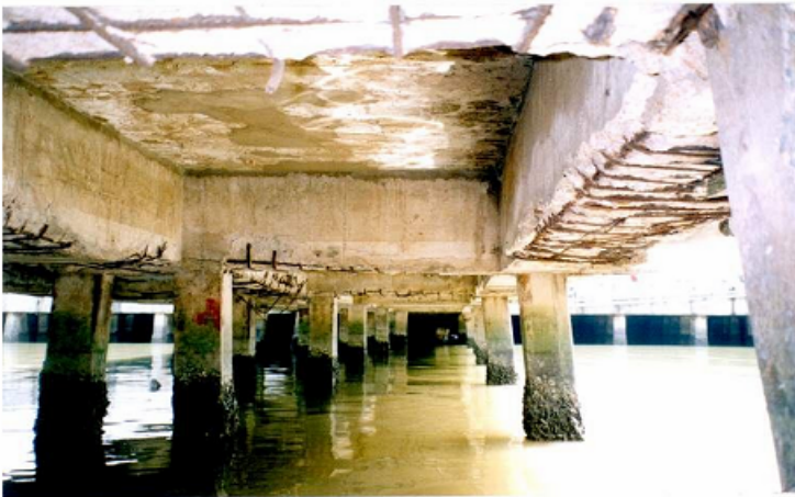
Hình 7- Nứt do ăn mòn cốt thép trong bê tông
