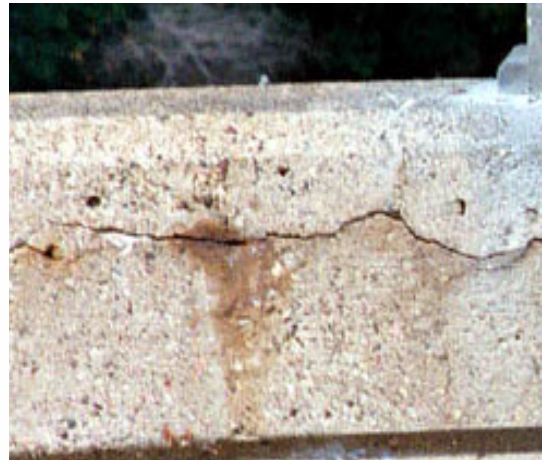
Hình 7- Nứt do ăn mòn cốt thép trong bê tông
