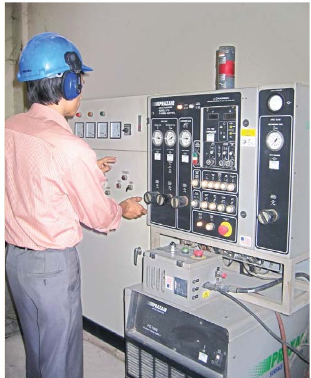
Vận hành thiết bị phun nổ
